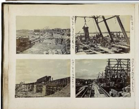
潜水函沈下準備工事之全景・工事風景・原動力工場汽缶・大洪水後之景・鋼桁組立作業／他
