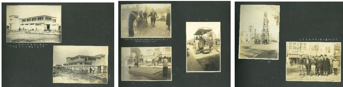
東京慈恵病院開院式・銀座線工事（京橋／他）・道路舗装工事（高田馬場）・ダム建設／他
