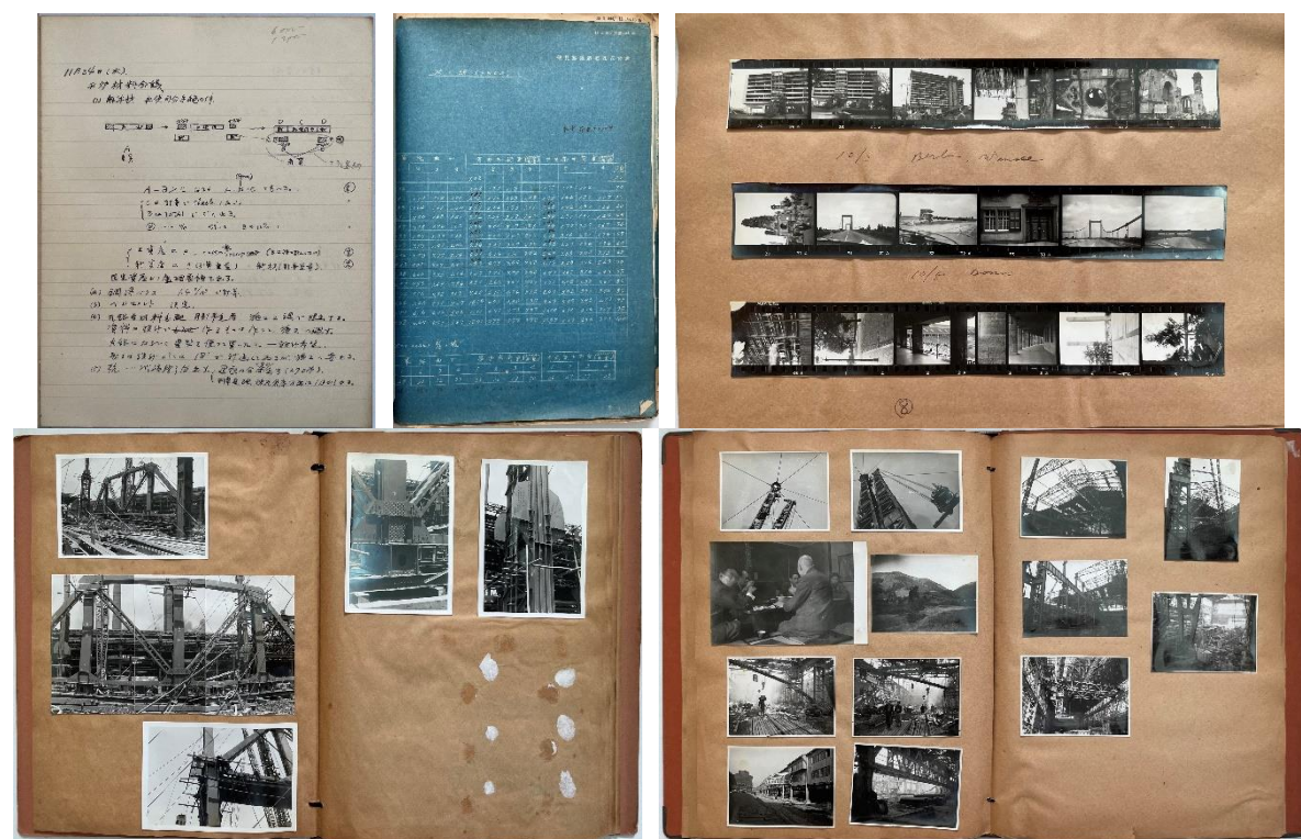
平炉・造船などに関する資料・直流電動機や工場建設などを写した写真・建築鉄骨工事施工技術問題集／他
